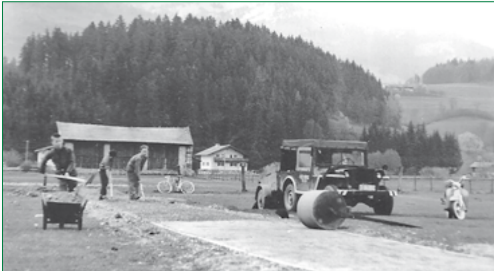
Arbeiten am Turnplatz
